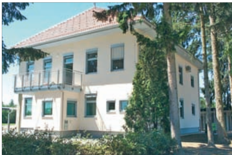
Slika 2: Sedanji (nov) objekt EVSP
