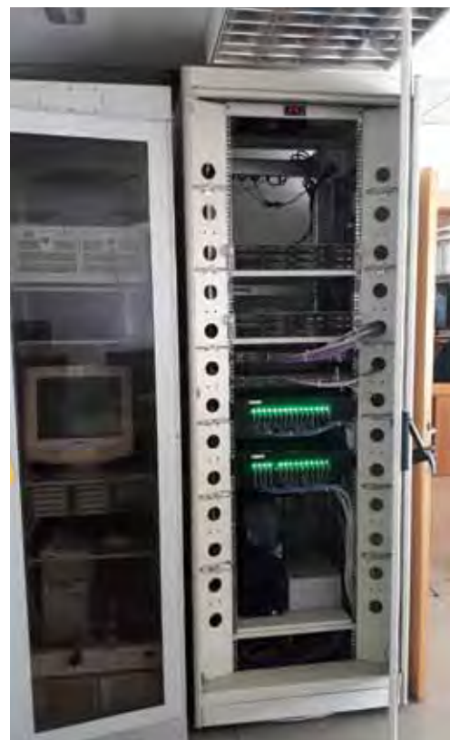
Prenos signalov iz sistemov tehničnega varovanja je prek optičnih povezav speljan v varnostno nadzorni center dežurne službe Centra za varovanje in zaščito. Foto: Marjan Ferk, CVZ GPU
