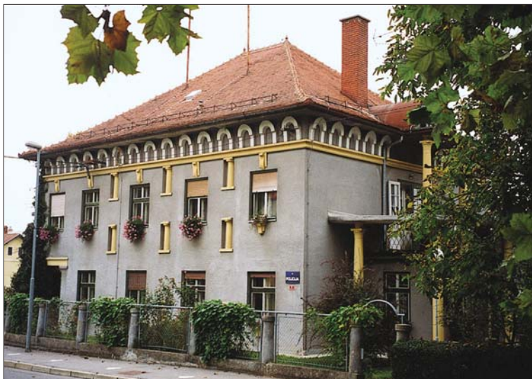
Nekaj policijskih postaj je še vedno v starih zgradbah (PP Gornja Radgona).
